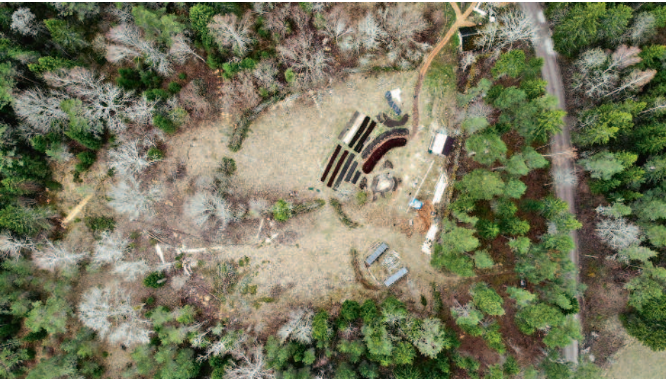
Luchtfoto van ‘Viibemaa’, de plaats in het oeroude bos waar het houten huisje van Jonas en Laura wordt gebouwd. In de cabine waar ze voorlopig wonen, kan het zeer koud worden.
